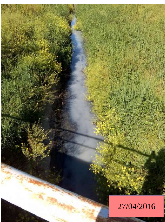
Foto n 24- Fosso Martello a valle immissione canale il giorno 27/04/2016
