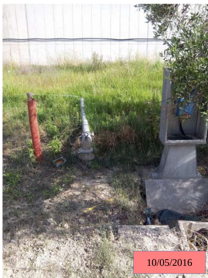
Foto n 3/4– Immagine immissione acqua nel Canale dalla tubazione della rete irrigua del Consorzio Bonifica Grossetana.
