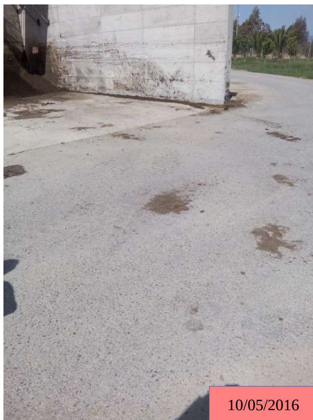
Foto n 22 – Platea digestato solido senza sistema di raccolta AMDC.
