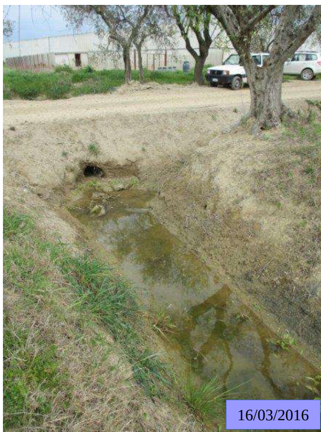
Foto n 3/4– Immagine immissione acqua nel Canale dalla tubazione della rete irrigua del Consorzio Bonifica Grossetana.
