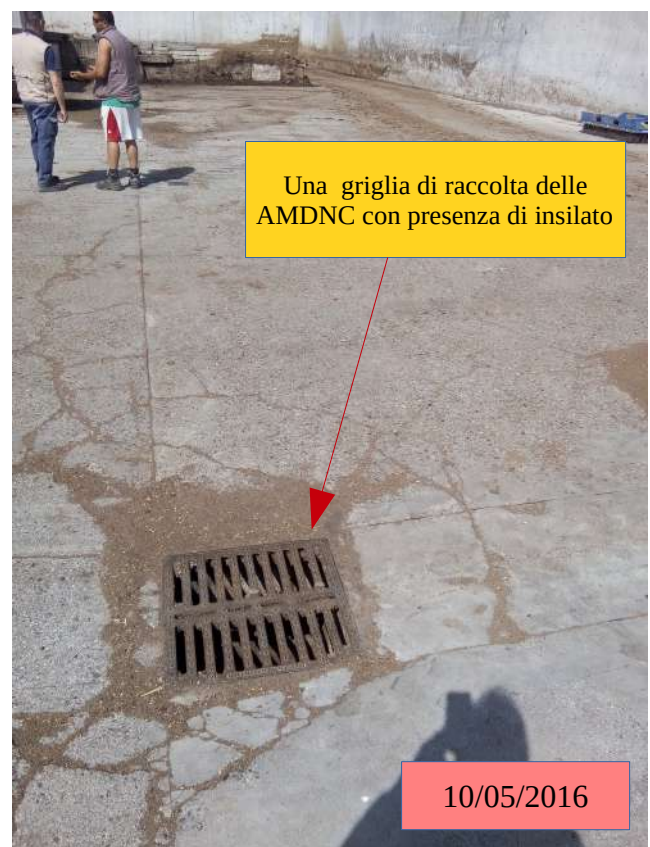
Foto n 20 – Griglia raccolta AMDNC con insilato
