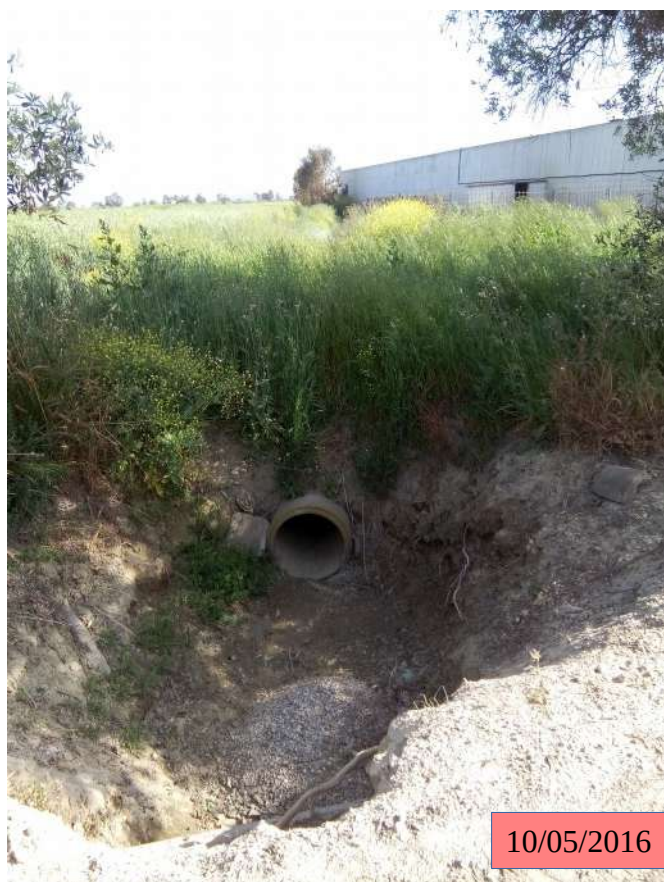
Foto n 3/4– Immagine immissione acqua nel Canale dalla tubazione della rete irrigua del Consorzio Bonifica Grossetana.
