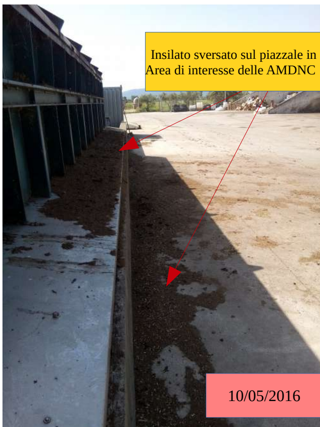
Foto n 19 – Esterno tramoggia di carico presenza di insilato
