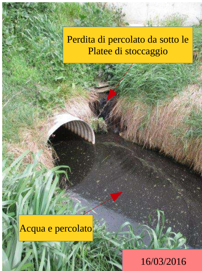
Foto n 10-Canale lato Ovest come era il 16/03/2016
